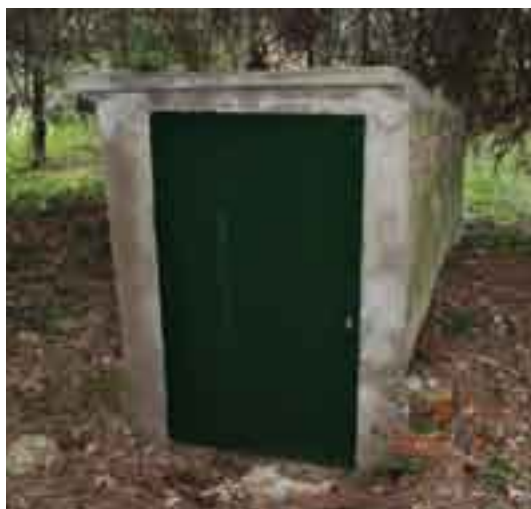
Portes de ferro als pous de les antigues mines
